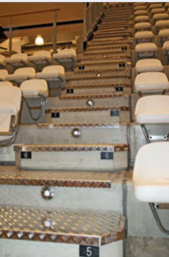
Verlijmen van aluminium tranenplaten in het topsportcentrum te Almere.
