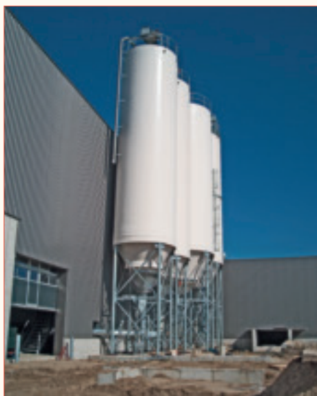
De nieuwgebouwde Lentse Potgrond-fabriek heeft een productiecapaciteit van driehonderdduizend kuub per jaar; in grote silo's worden de diverse grondsoorten en meststoffen opgeslagen.
